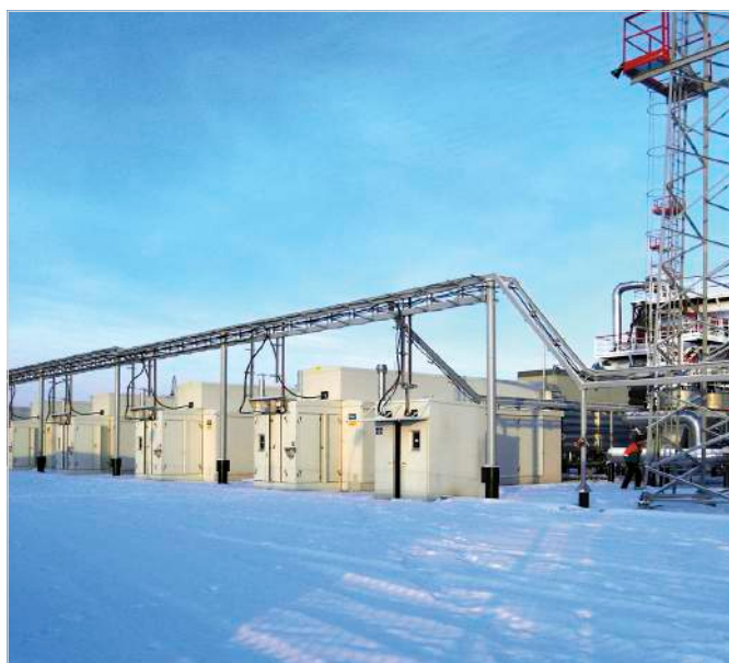
Фото 1 — Компрессорные установки Enerproject типа EGSi-S-650/1500WA для компримирования ПНГ
