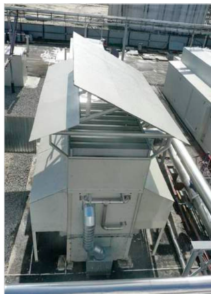
Фото 4 — Аппарат воздушного охлаждения после модернизации системы теплообмена
