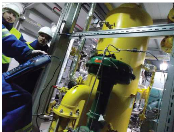
Рис. 4 — Пуско-наладочные работы станции для РН-Уватнефтегаз
